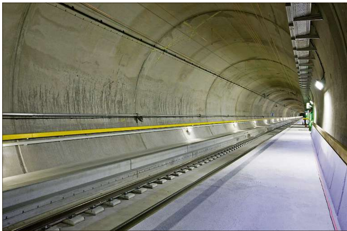
Die Neat, im Bild der Gotthard-Basistunnel, wird die Fahrzeiten ins Tessin erheblich verkürzen.
